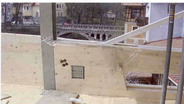
Durch den Vergütungseffekt der Querlagen können hohe Druckkräfte wie hier im Bereich der Diagonalenverankerungen auf sehr kleiner Fläche in das Brettsperrholz eingeleitet werden.
